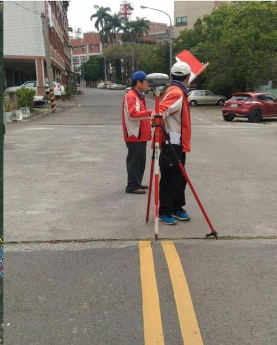
圖 5-8 e-GNSS 外業測量
