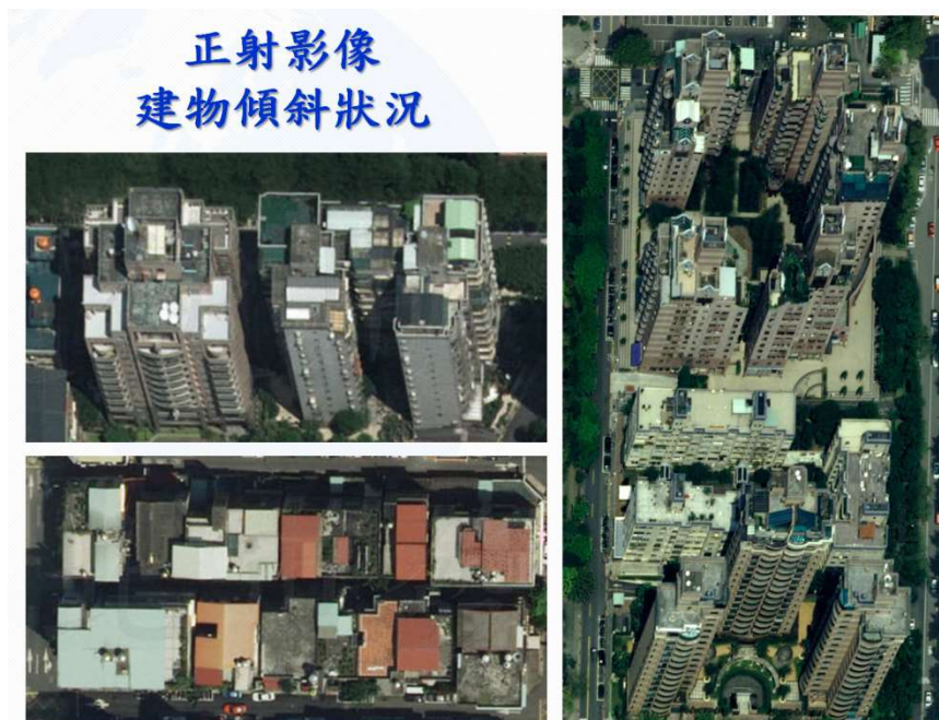
圖 4.22、正射影像建物傾斜狀況
