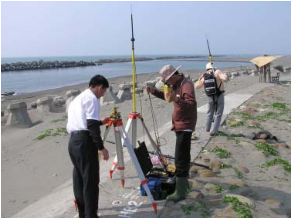
圖 9 主站架設作業情形
