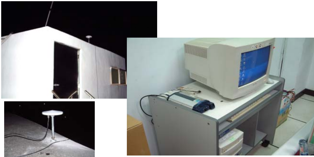
圖 5-2 旗山地政事務所電腦、接收儀、天線盤設置地點及設站情形
