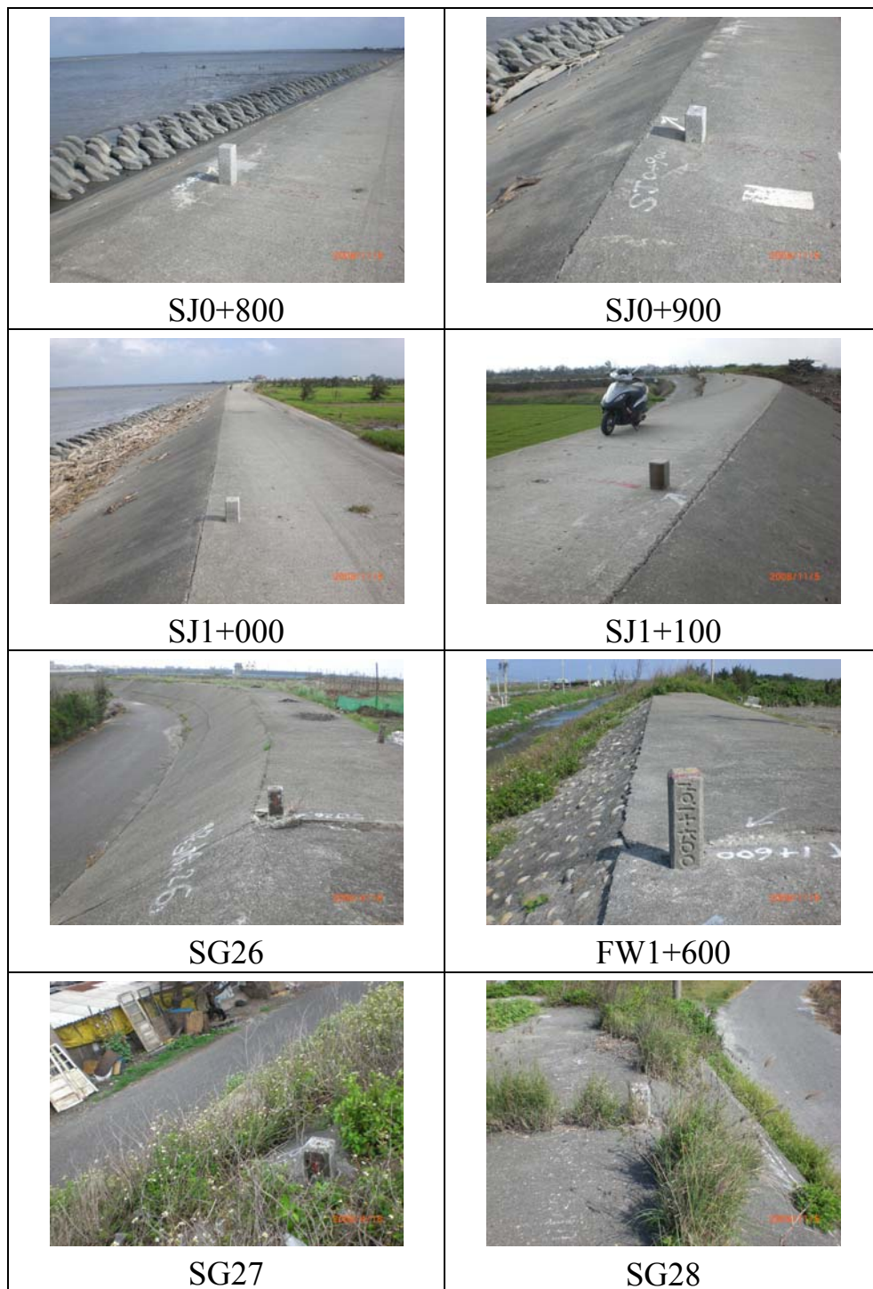
圖 5- 59 樁位處之點位現場照片 2
