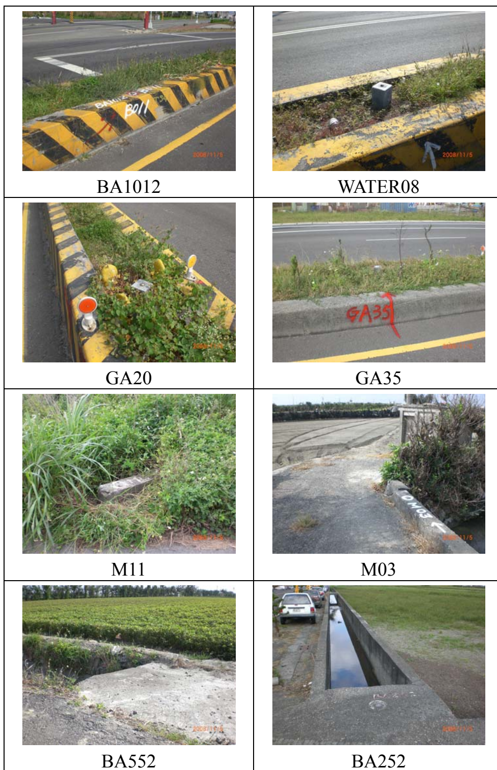
圖 5-57 人工結構物處之點位現場照片 2
