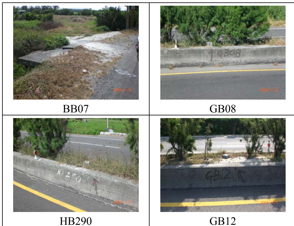
圖 5-56 人工結構物處之點位現場照片 1
