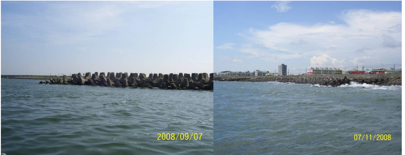
圖 21、興達北側固砂突堤工作照
