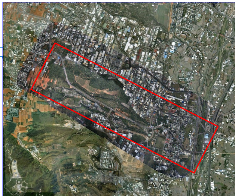
★特3號道路完工後影像
