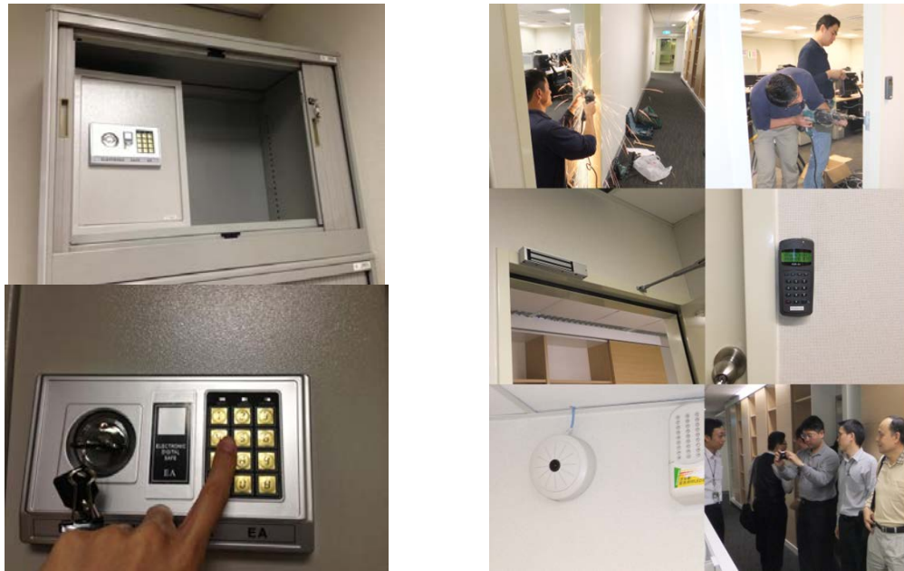
圖 3.1-1 機密管制室建置
