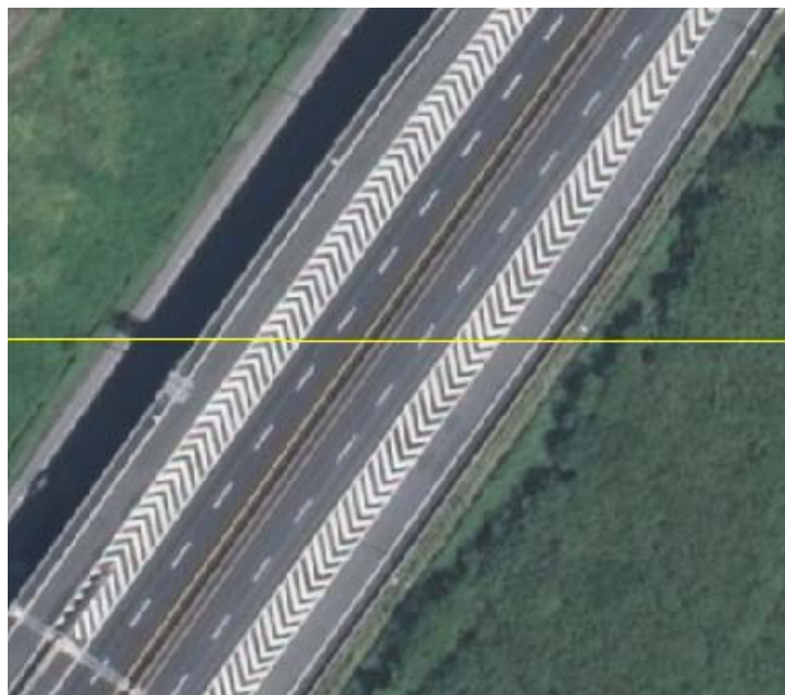
圖 5-43、第 3 作業區影像接邊情形
