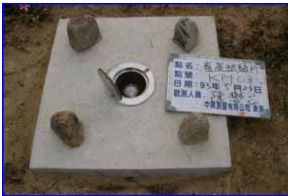
圖 3-4 第二次混凝土灌漿
