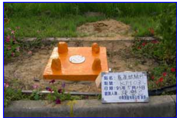
圖 3-5 點位埋設完成
