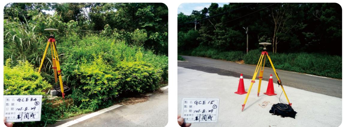
▲ 圖 4-16 協助辦理加密控制測量作業情形
