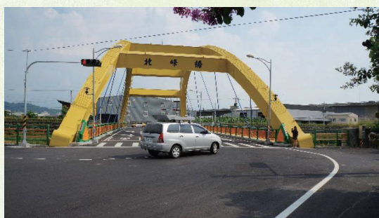
圖 8-4 測繪車拍攝霧峰北峰橋
