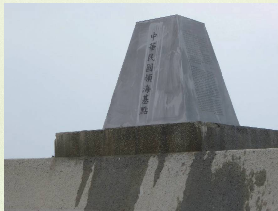
圖 8-41 領海基點樁建置成果 (基點樁柱記載點名、領海基點說明等資料)
