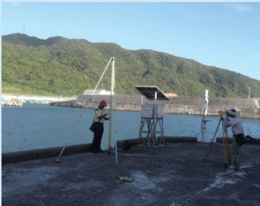
圖 5-16 離島水準點測量作業
