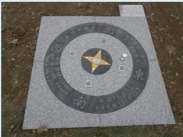
圖 5-11 代辦基隆市一級加密美化控制點設置 圖 5-12 代辦苗栗縣一級加密控制測量作業
