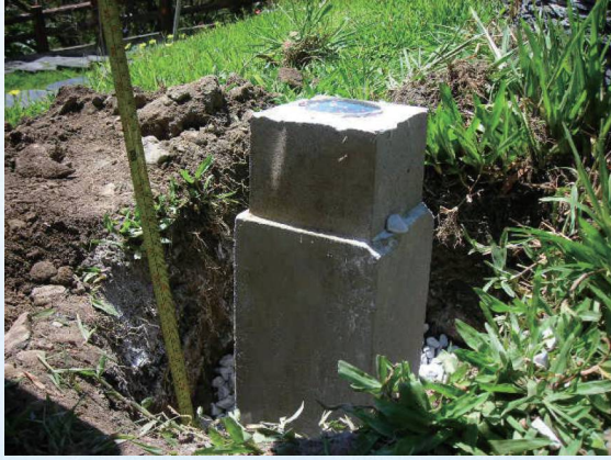
圖 5-2 三等控制點標石埋設作業
