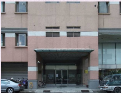
南區第一測量隊隊部辦公室 (4 樓)
