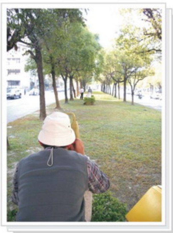
▲圖4-63 固定基座基線場
