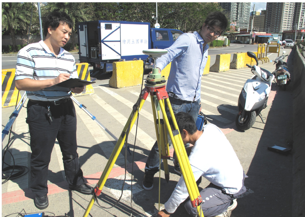
圖 4-12 現場定位作業檢查（儀器架設）
