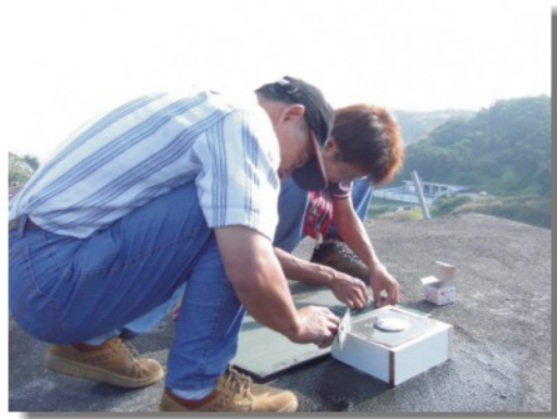
圖 3-2 埋設四等控制點鋼標
