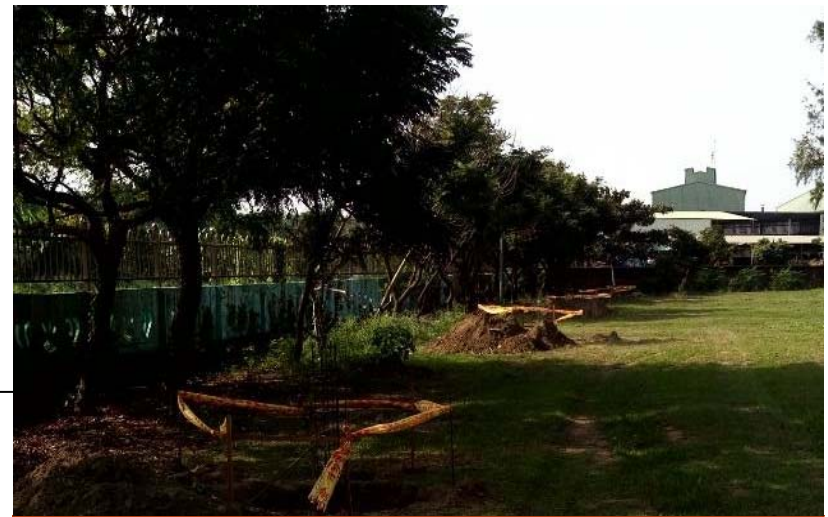
臺南市政府簡易基線場施工現場
