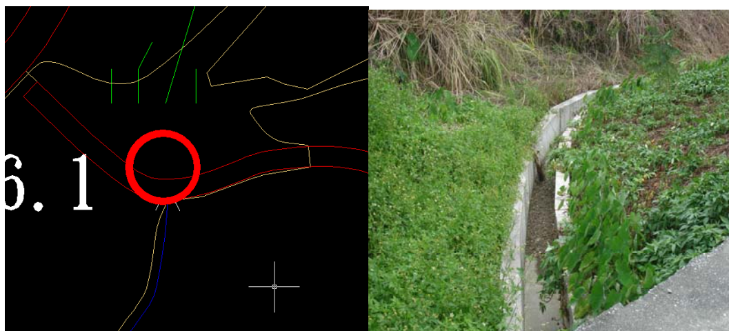
圖 3-8-9 96191020 錯誤情形(漏繪溝渠)
