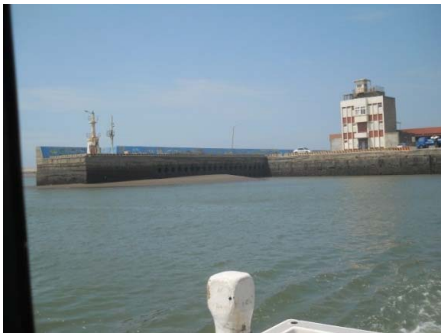
圖3-52、新竹漁港安檢所前淤砂情形-位置1
