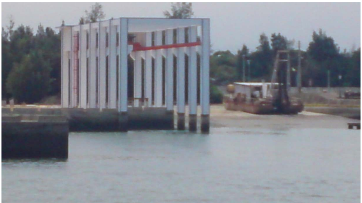
圖3-60、龍鳳漁港港區曳船道照片-位置1
