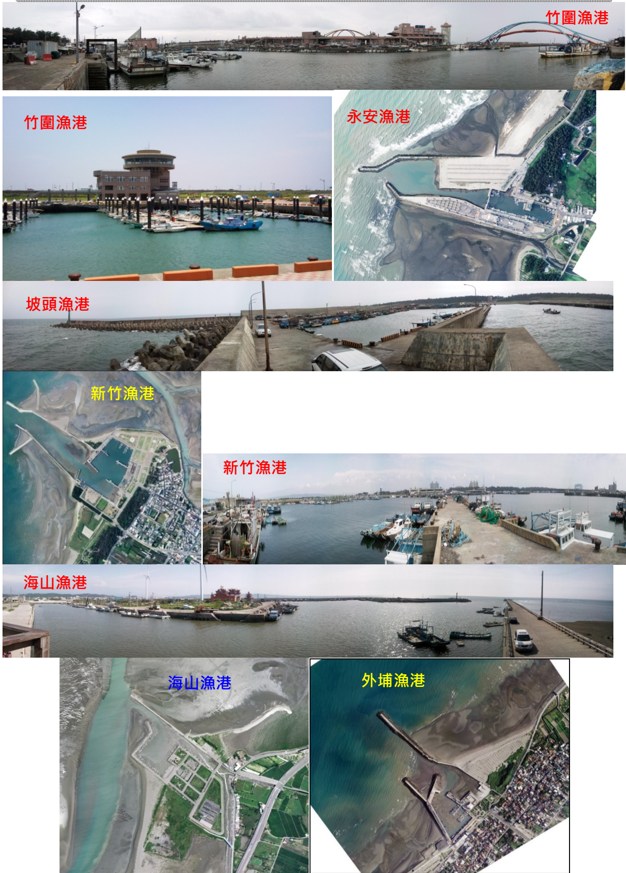
圖2-5、桃竹苗海岸漁港航拍影像及現況照片
