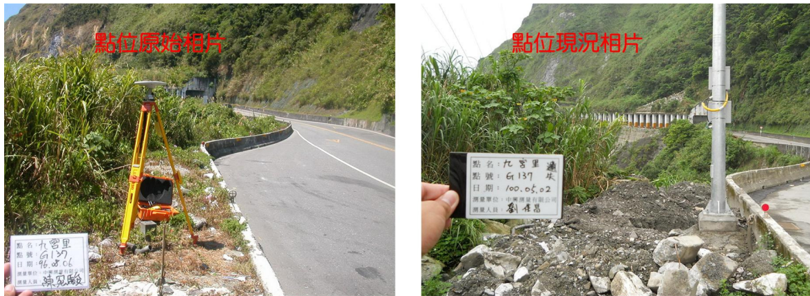
圖 2-3 因山區坍塌遺失點位
