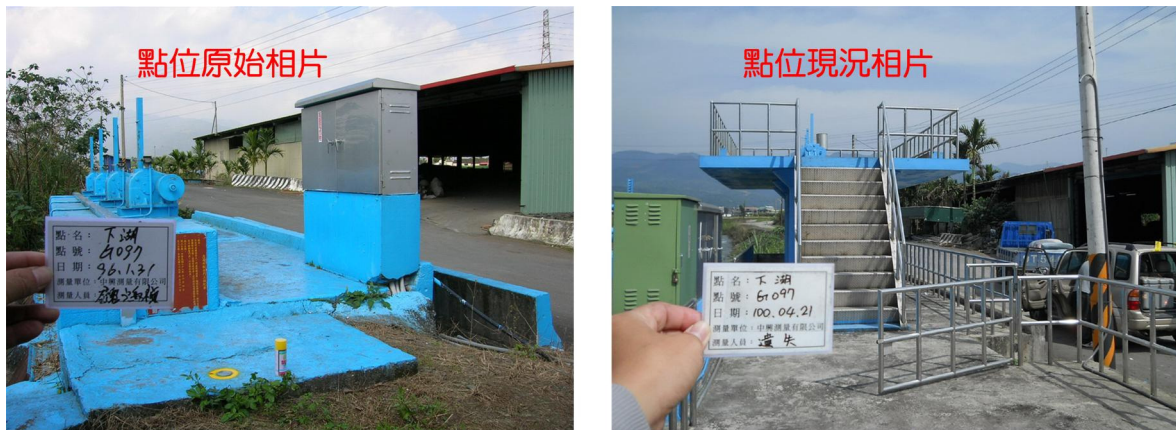
圖 2-4 因工程施工而遺失之點位
