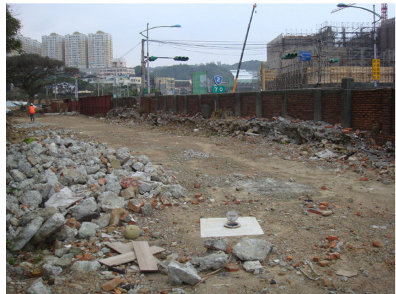
圖 2-9 新水準原點施工完成相片
