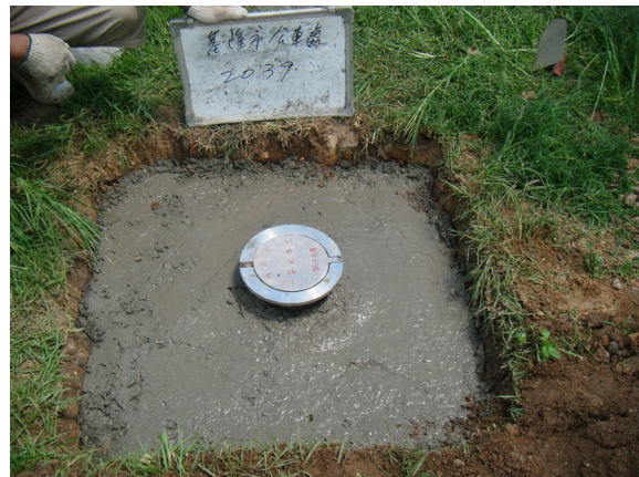
圖 4-5 第二次混凝土灌漿
