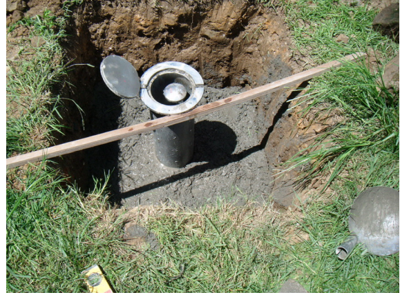
圖 4-3 第一次混凝土灌漿
