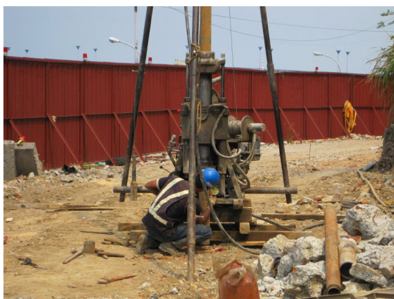
圖 2-3 架設鑽機
