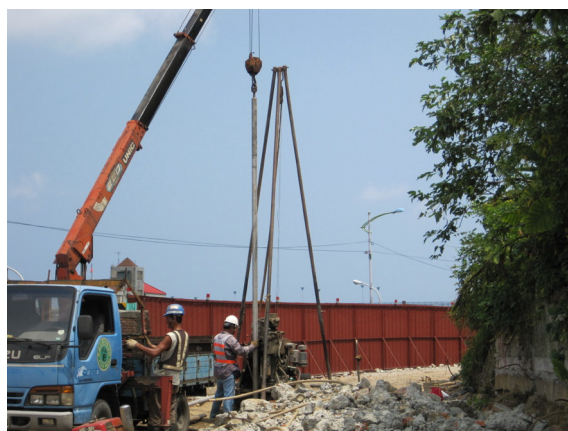
圖 2-6 置入不銹鋼管
