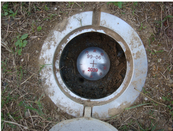
圖 4-6 水準點埋設完成相片
