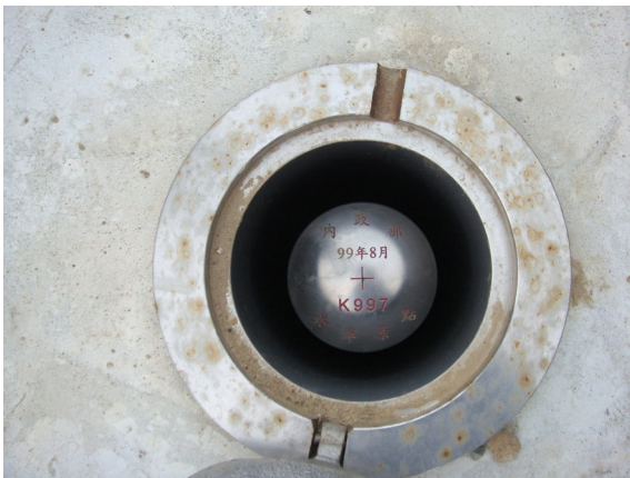
圖 2-9 新水準原點施工完成相片
