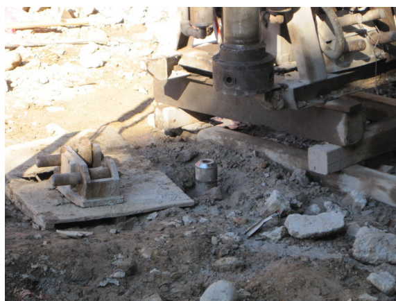
圖 2-12 衛星追蹤站鑽孔完成相片
