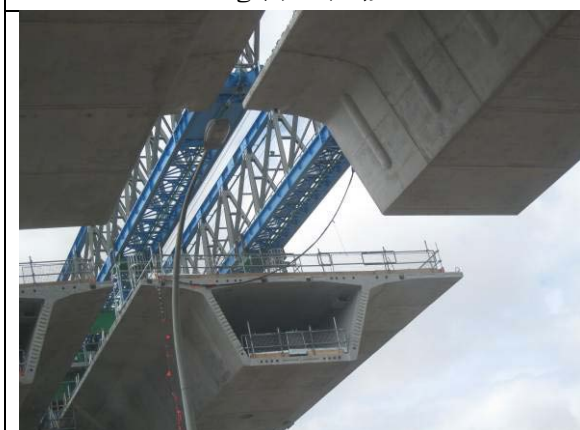
圖 53：南路高速公路預鑄混凝土節塊及支撐桁架
