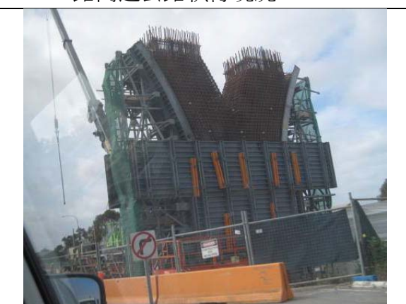
圖 52：南路高速公路橋墩組模
