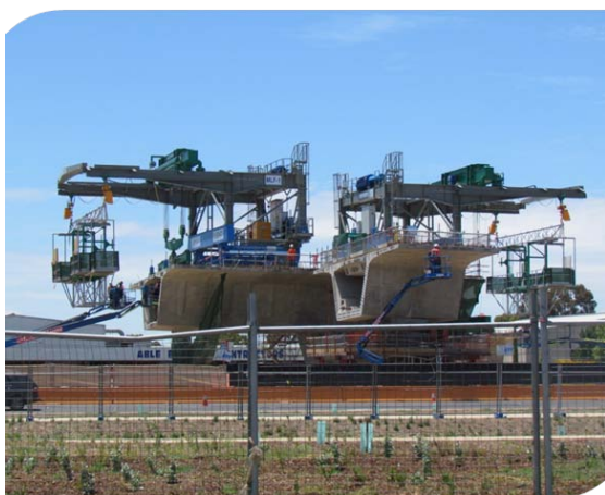
預力節塊吊裝(南澳州政府提供)
