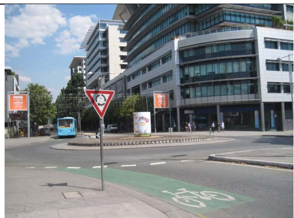
圖 20：布里斯本市區路口圓環，減少交通號誌、線路設置及後續維管之費用
