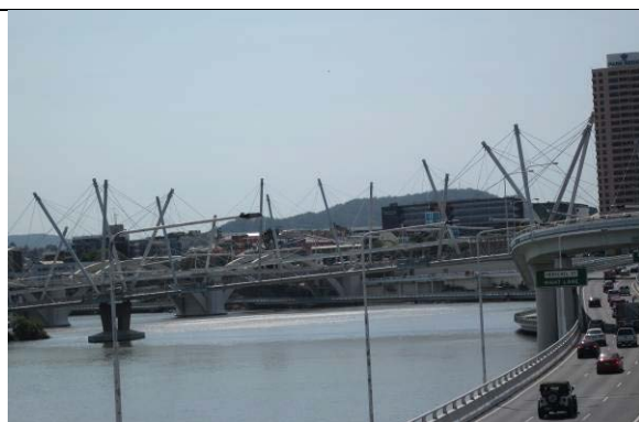
圖 2：跨越布里斯本河之特殊造型人行橋
