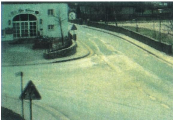
更新前的道路交叉口
