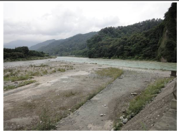
圖 24：都江堰水利工程第二部分「飛沙堰」側向溢流堰
