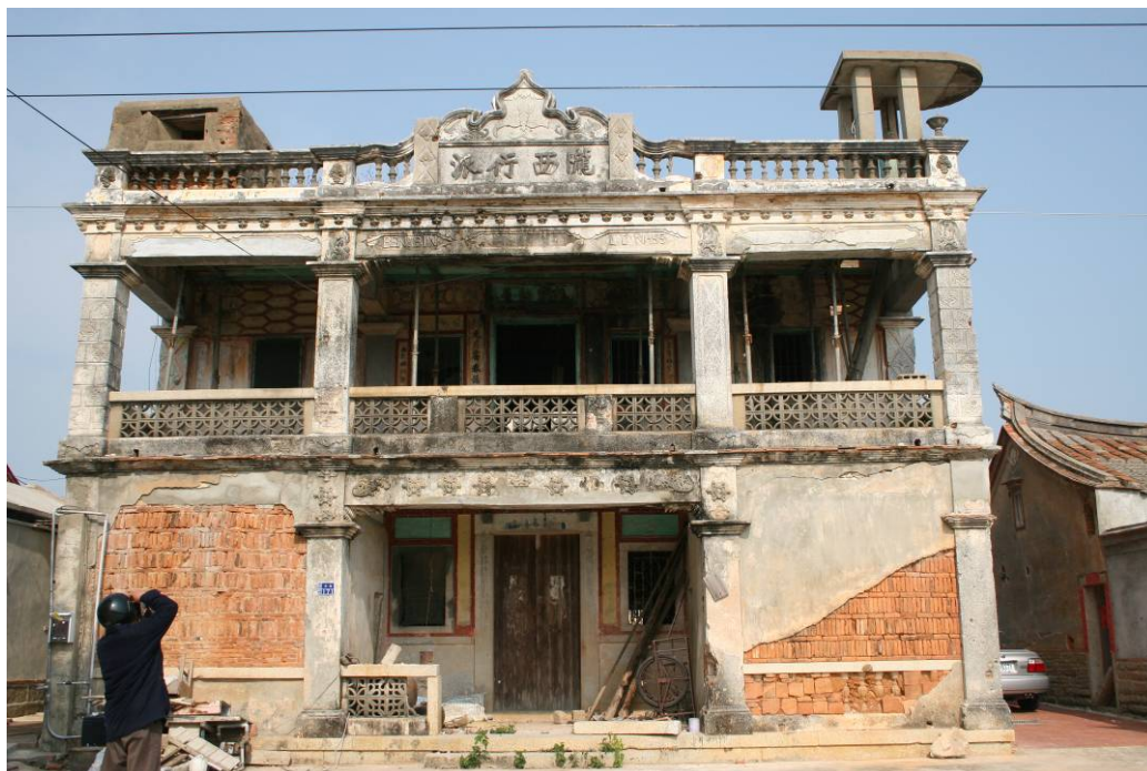
圖 5-1-1 未整修前的北山李森極洋樓。
