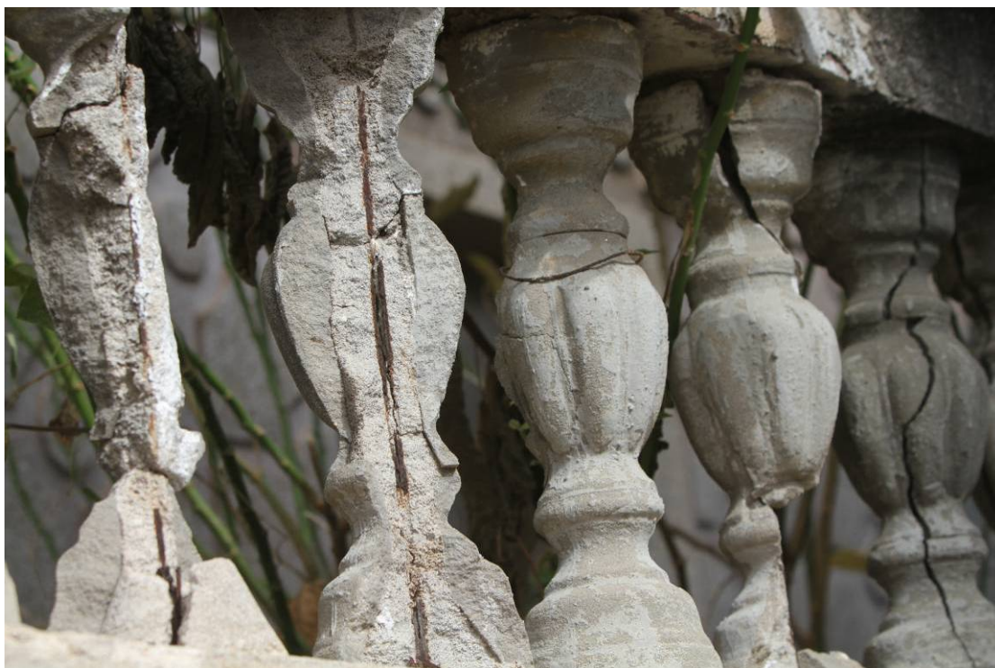
圖 4-1-3 水泥灌模欄杆瓶柱的內部結構。
