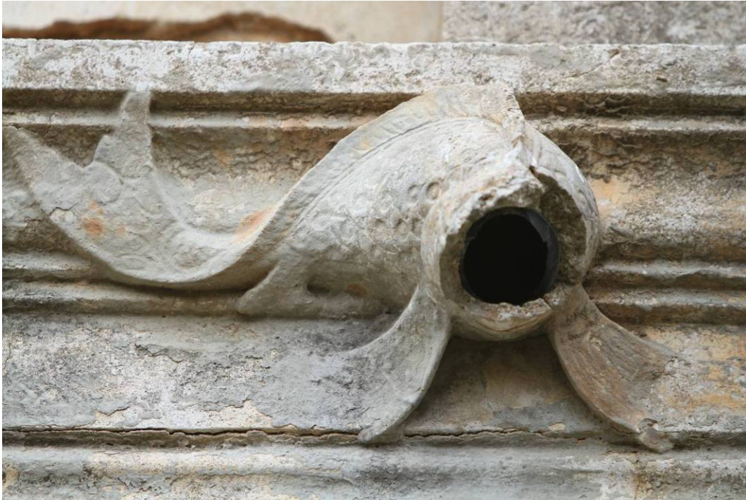
圖 4-3-3 東蕭洋樓魚類造型落水口。
