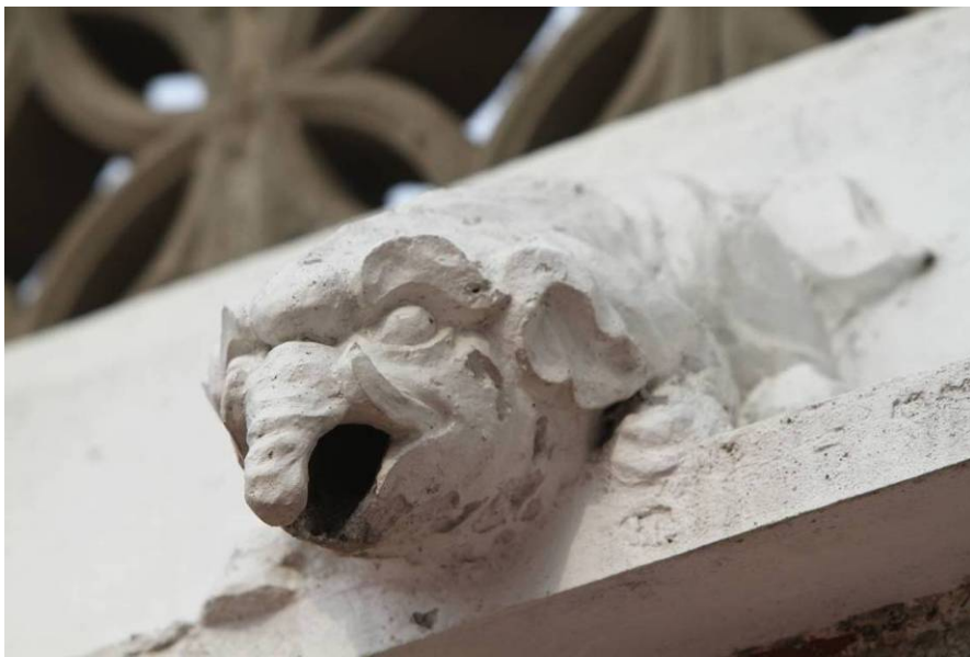
圖 4-3-12 官澳洋樓的大象造型落水口。
