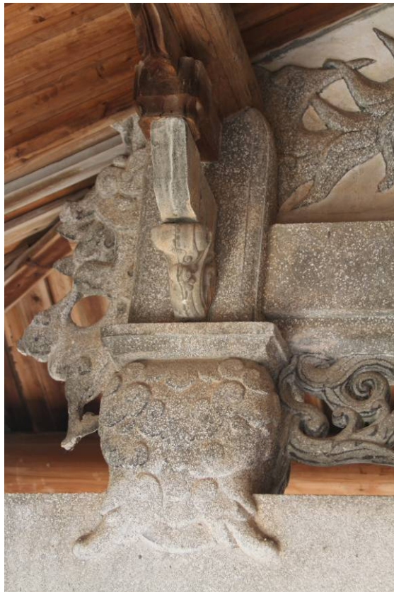
圖 4-1-2 碧山陳氏宗祠水泥灌注的樑柱斗拱構件。
