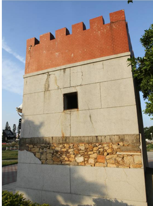
圖 3-1-24 後浦頭川德宮前的礮樓。
