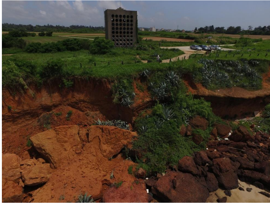
照片 6-6 2016 年 5 月 22 日北山播音牆前發生海崖崩塌
