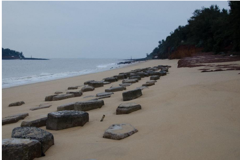
照片 5-3 2016 年 3 月烈嶼南山頭海灘照片，經過東北季風帶來的泥沙回補，原本露出的消波塊又被泥沙覆蓋，僅露出最上方小部分
