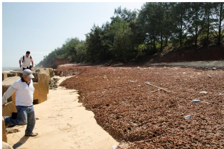
照片 5-2 2015 年颱風後烈嶼南山頭海灘照片，消波塊已經露出約 0.8 公尺
