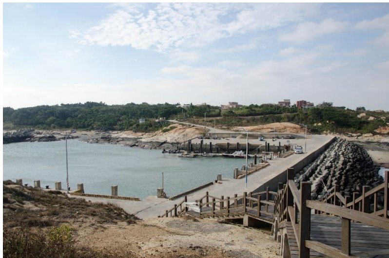
照片附 2-31 從復國墩的礁石步道回望港區，可見到仍供修築的海堤將顯礁與陸地連接，使海堤的內側成為良好的避風區
