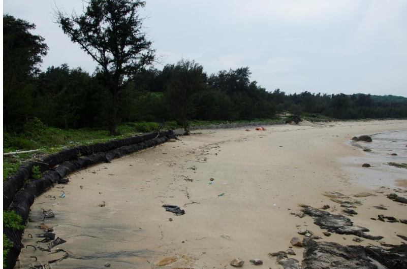
照片 5-7 后嶼坡海灘後方的定沙編柵(照片中黑色處)，尚能夠抵擋海水的衝擊而未受損，然而遠方的浮筒已經被翻面了
