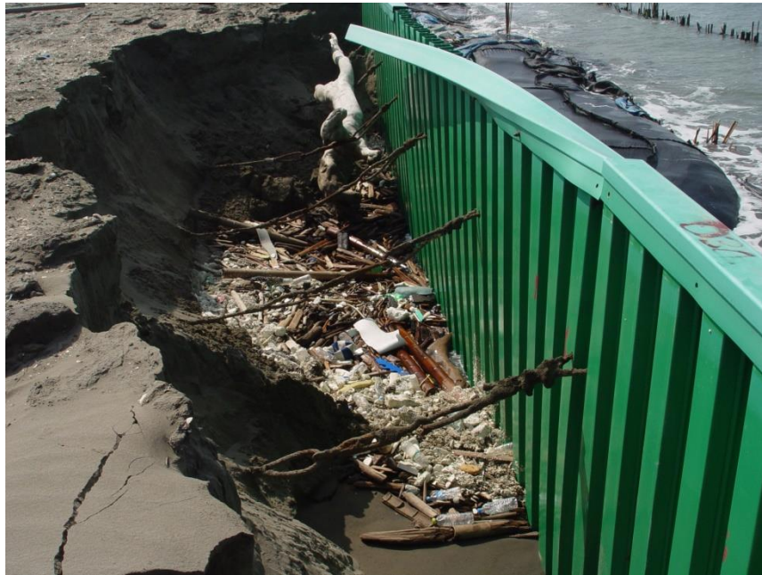
圖 5.2.6 在鋼板樁後方有造成侵蝕的可能性
