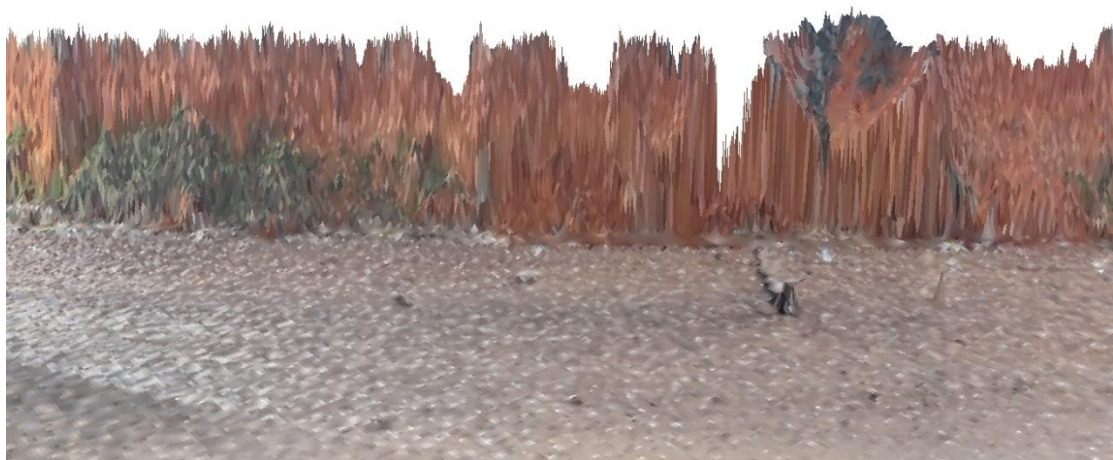
圖 3.5.6 2016 年 11 月北山海崖邊坡原本崩塌崖錐處 (下邊坡原本明顯突出的堆積崖錐已大部分消失)
