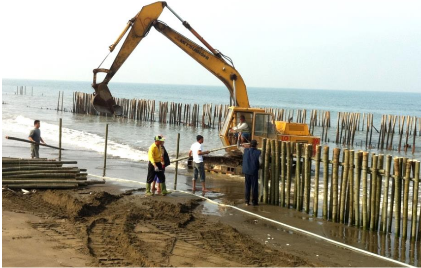
圖 5.2.2 台南七股海岸在垂直與平行海岸線方向插竹竿，進行海岸侵蝕防護
