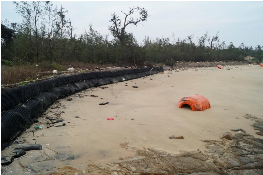
照片 3.4.4.4 2016 年 11 月 03 日的後嶼坡海灘
