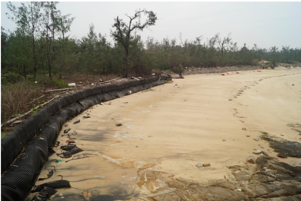
照片 3.4.4.3 2016 年 11 月 20 日的後嶼坡海灘
