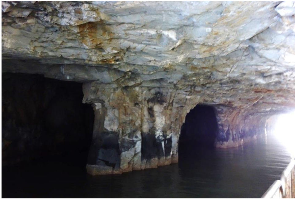
照片 附件三. 14 九宮坑道內的分支坑道
