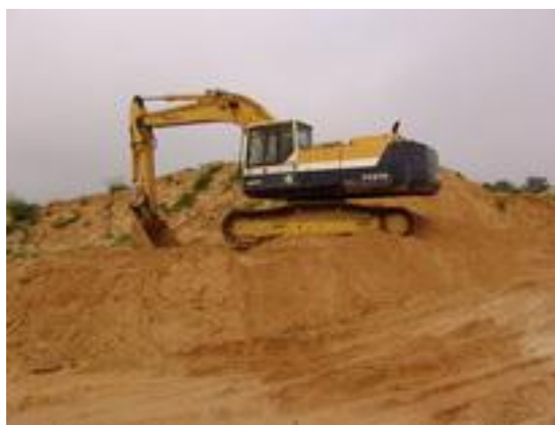
八月上旬遭開挖破壞的栗喉蜂虎營巢地
