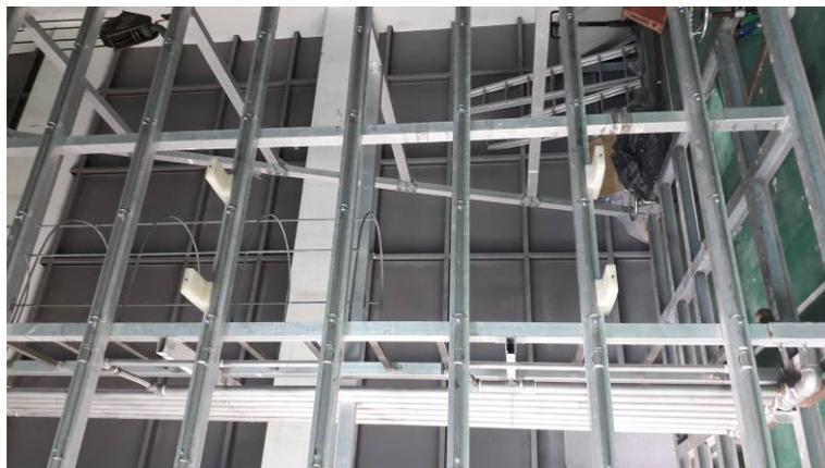
圖 2-3 安裝風速計骨架
