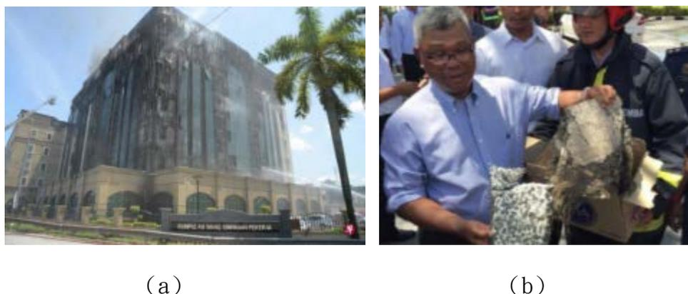
圖 2-16 (a)僱員公積金局火災後外觀及(b)保麗龍裝飾外牆的殘塊[22]
