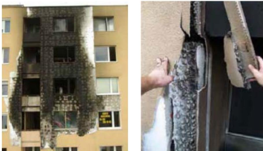
圖 2-11 外牆外隔熱及防水裝飾系統EIFS火災[15]
