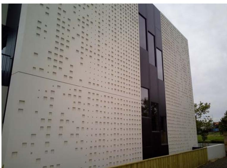
**圖 2-5 澳洲墨爾本建築物 PU 節能外牆實例**
