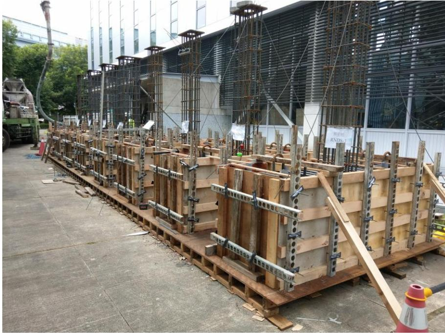
圖 3-3 試體混凝土澆置(基座)
