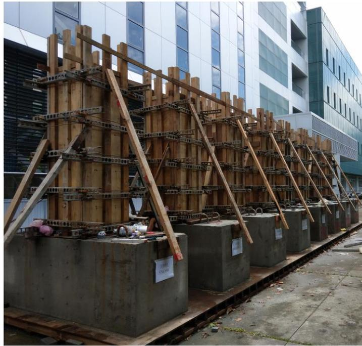
圖 3-8 試體模板組立(柱)
