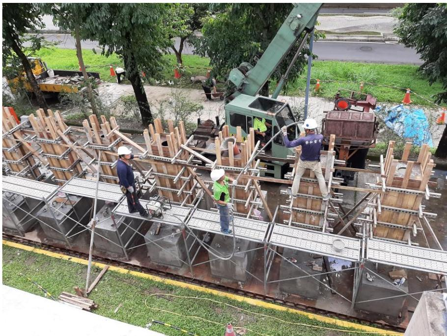
圖 3-9 試體混凝土澆置(柱)
