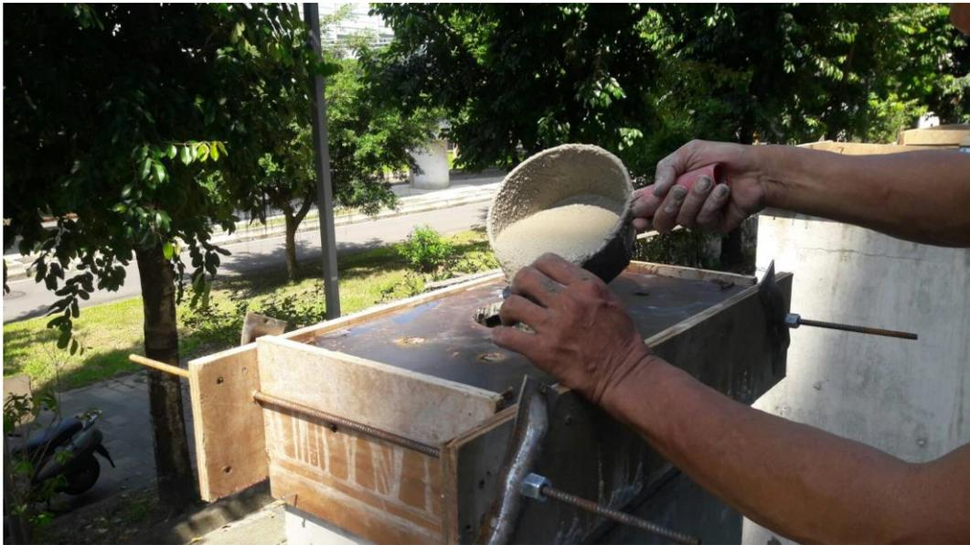
圖 3-10 試體柱頂灌注無收縮砂漿
