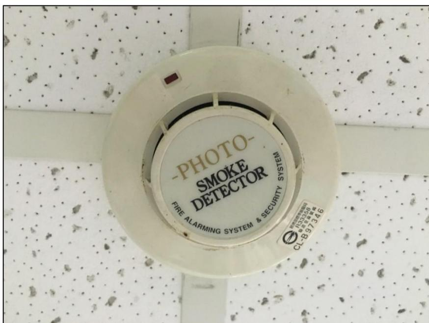
圖 3-1 光電式偵煙探測器實景圖
