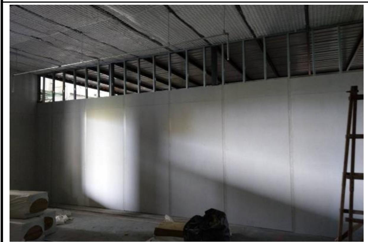
圖 3-15 實驗屋分隔火災室與非火災室之隔間牆
