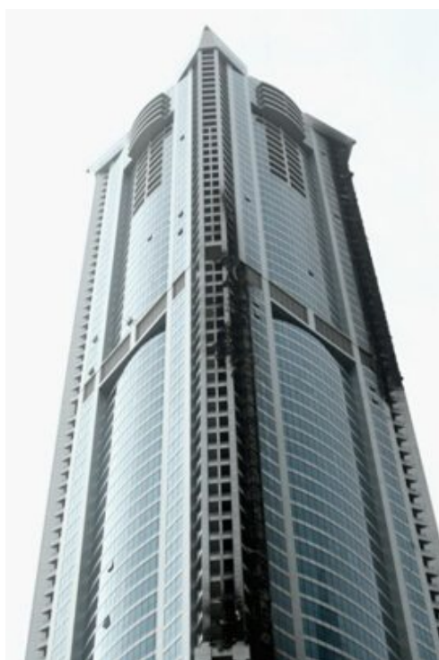
圖 3- 11 火災撲滅後可見大廈多處燻黑 80
