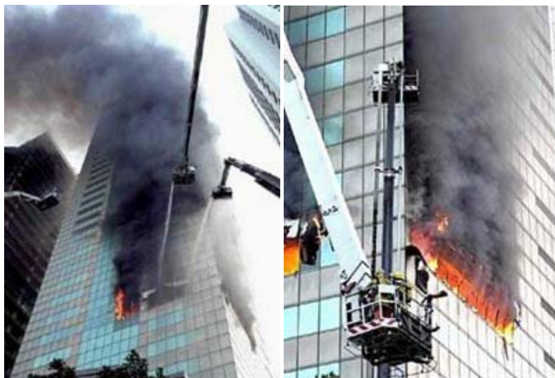
圖 3-1 東帝士摩天大樓當時 10 樓火災情形 49
