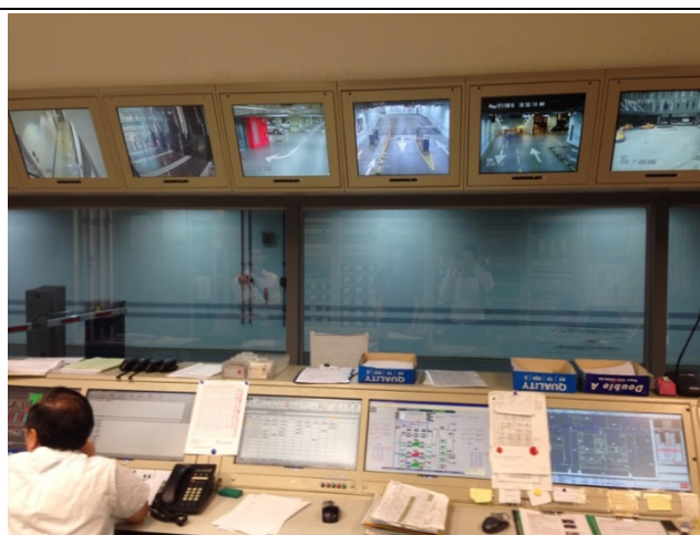
高透視玻璃，防災中心兼做汽車出入管理功能
