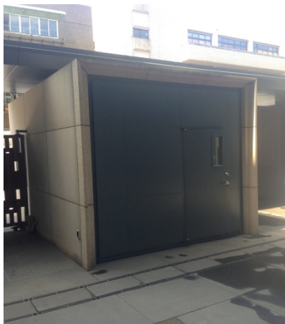
一樓警衛室外觀
