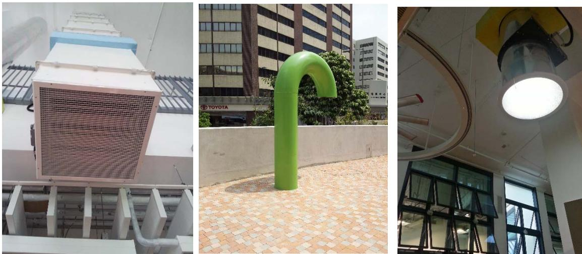
圖 3-1 香港零碳天地採用的捕風器、地冷管、導光管
