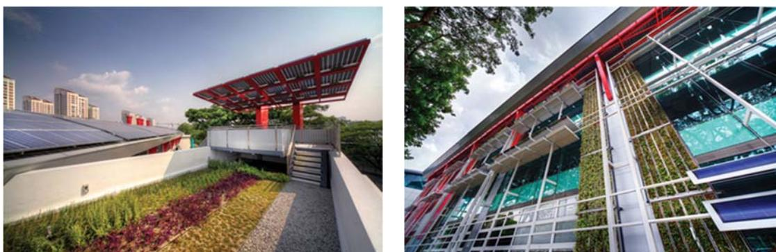
圖 3-14 「BCA Zero Energy Building」牆面及屋頂綠化
