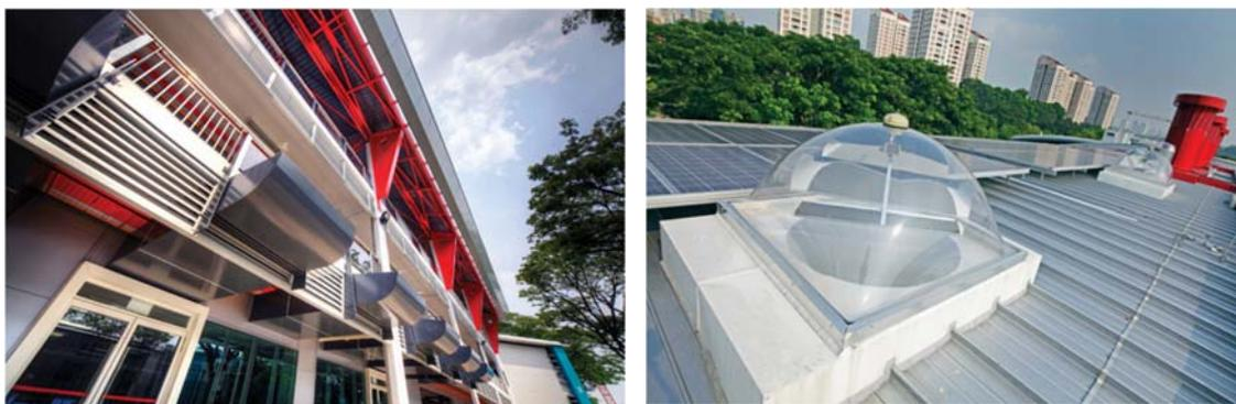
**圖 3-12 「BCA Zero Energy Building」的窗面與屋頂導光設計**
