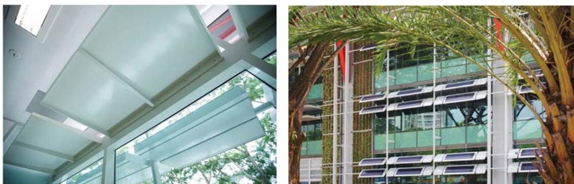
**圖 3-13 「BCA Zero Energy Building」的窗面外遮陽設計**
