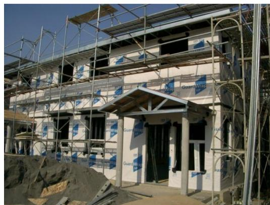
圖 1.3 輕鋼構建築(永久安置屋)
