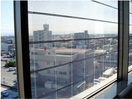
圖 1-2-3-8 非晶矽薄膜 BIPV 之透光性
