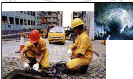
圖 7 香港防洪設施檢查情形（閉路電視檢查排水渠內的情況）
