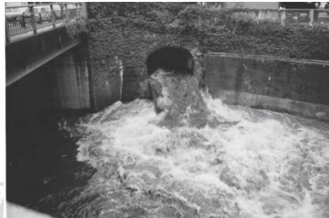
圖 11 合流式下水道(暴雨時)
