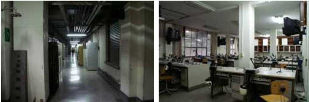
圖5-14 建築內既有管線與設備之調查記錄
