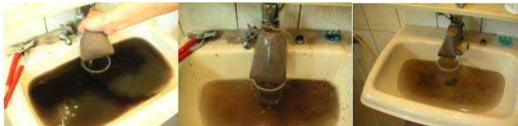
圖5-4 使用地下水管路清洗時水體情況
