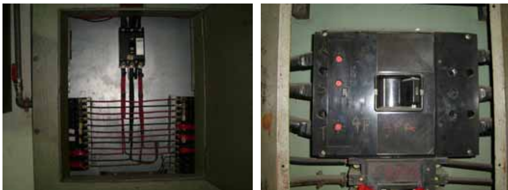
圖5-16 建築內既有水電系統荷載性能之調查記錄
