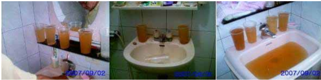
圖5-2 熱水管(鐵管)清洗時水體情況
