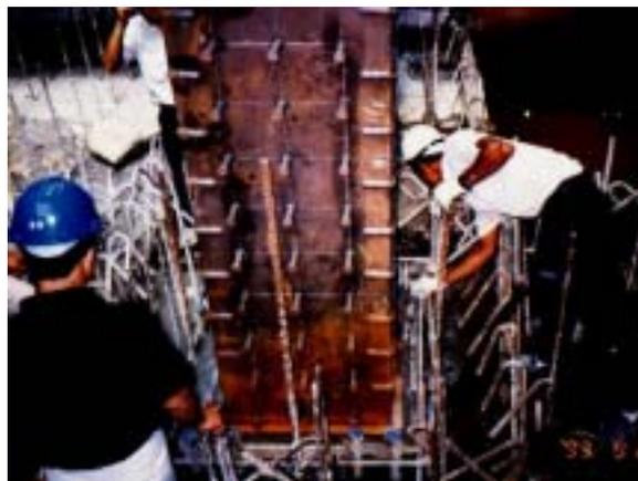
底板底面應設導氣槽及導氣孔，讓灌漿時向上擠壓之空氣得以順利逃出避免造成底部蜂窩，影響應力傳遞。
