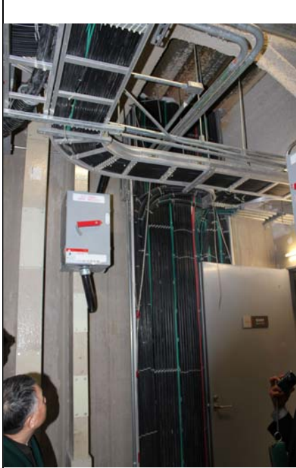
設置綜合佈線設備室配線設施
