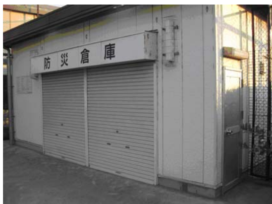
圖15 堀切二丁目防災公園—防災倉庫
