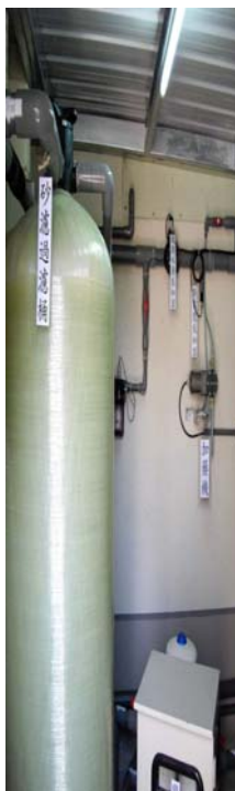
改善後：以完整過濾系統進行雨水再利用
