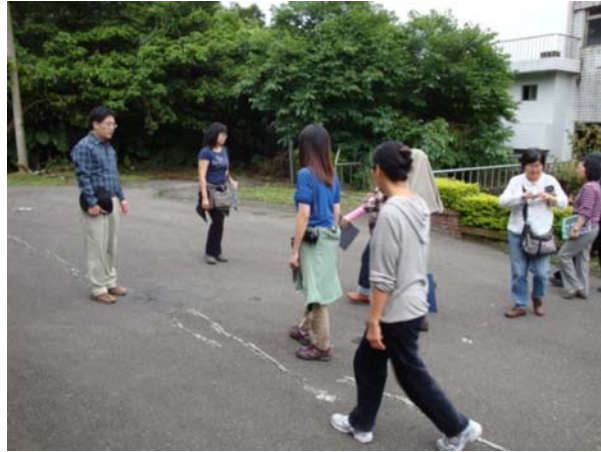
圖10邊坡道路出現裂縫
