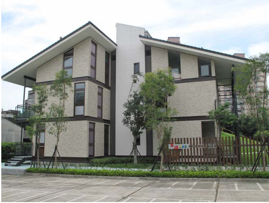
圖1 易構住宅實體照片
