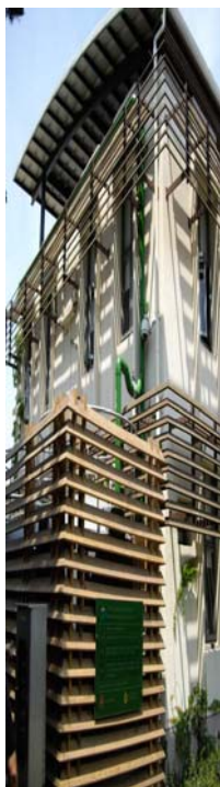
改善後：以南方松格柵美化雨水儲存設備
