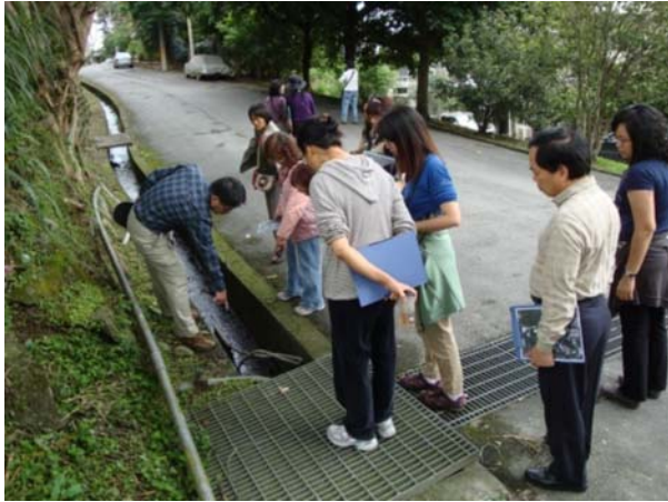
圖9 水溝有泥土漫流容易阻塞
