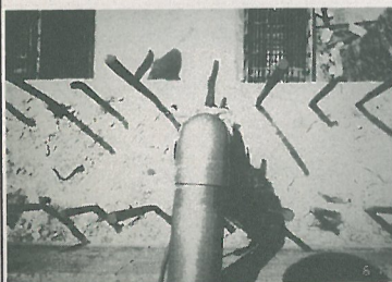
擋土壁中之水位洩降井
