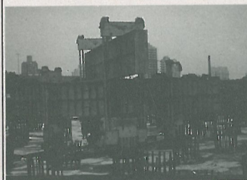
自動化樁載重量測
