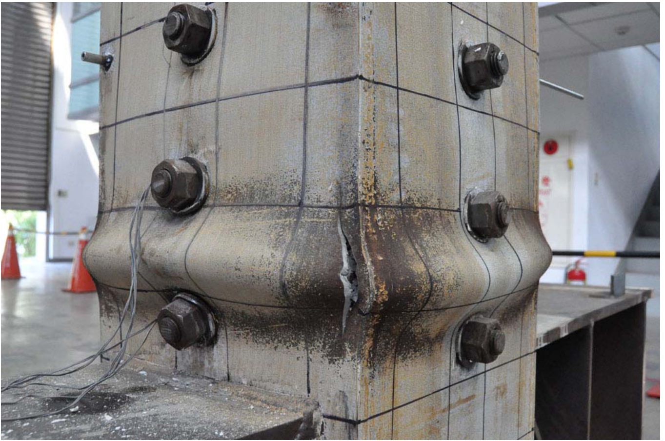
圖11 加裝圍束繫桿試體之破壞形狀與角落開裂照片
