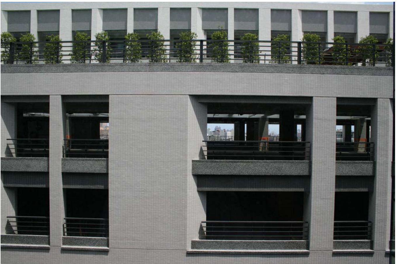
圖7 台達電子桃園三廠應用自然採光及通風降低熱島效應。
