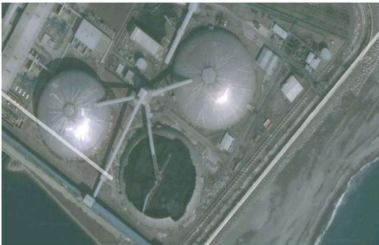
圖4花蓮和平電廠煤倉颱風破壞後之空照圖
