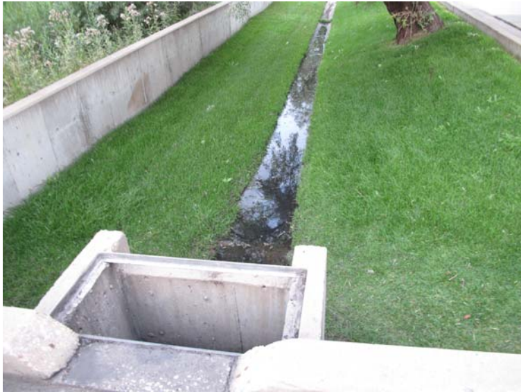
照片11 超大排水溝(一)
