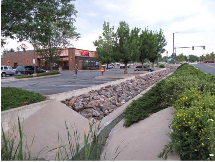
照片5 大排水溝
