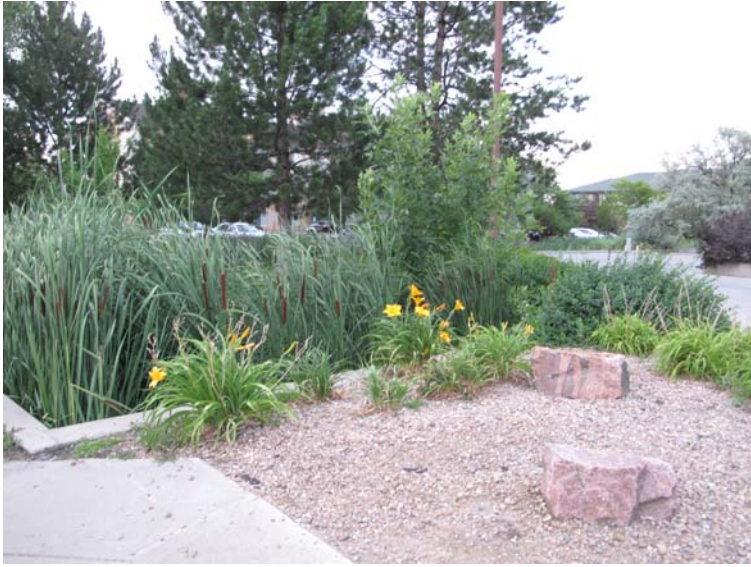
照片8 地表入滲工法(二)
