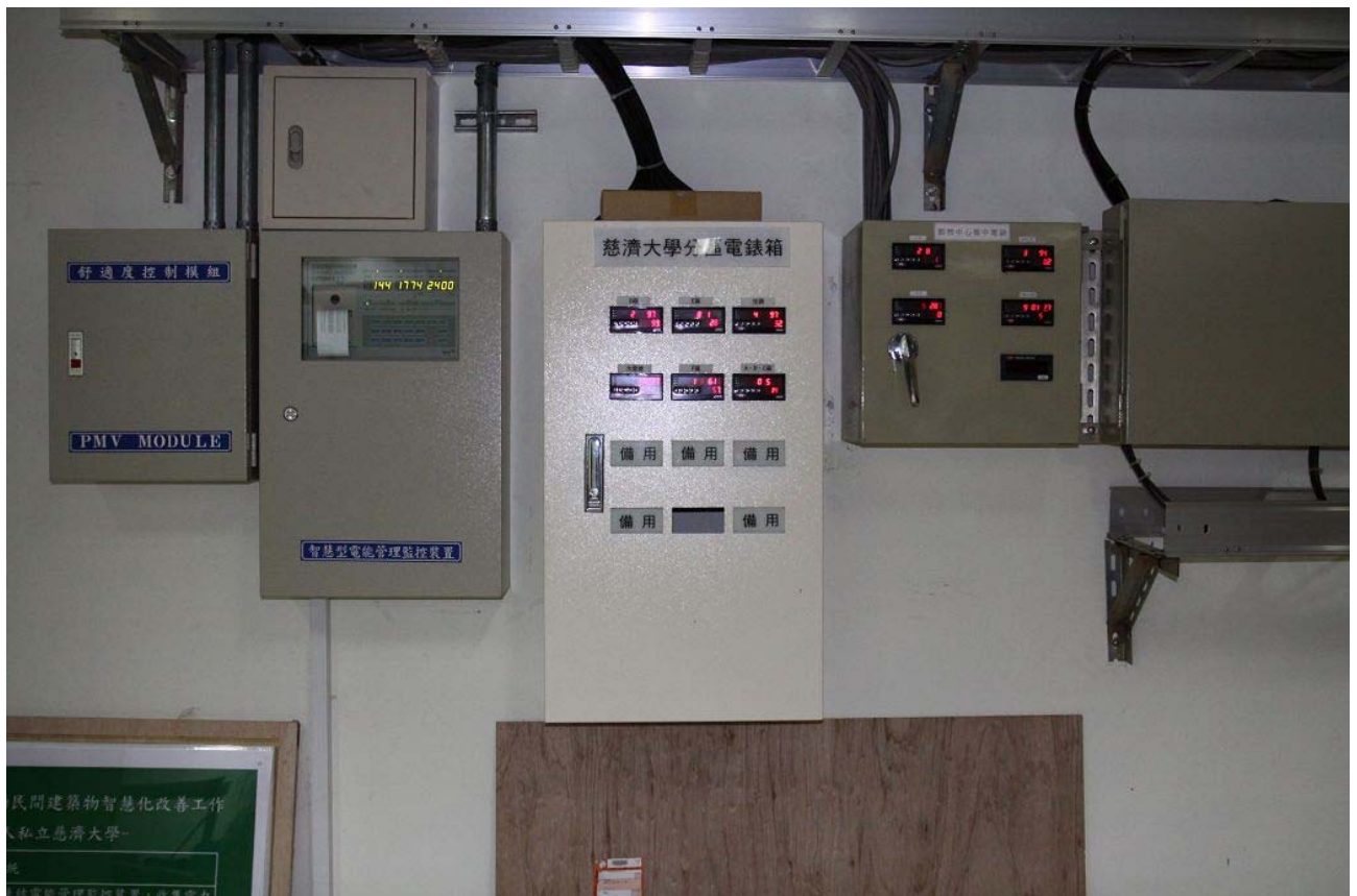
圖4 系統整合應用-慈濟大學能源監控配線
