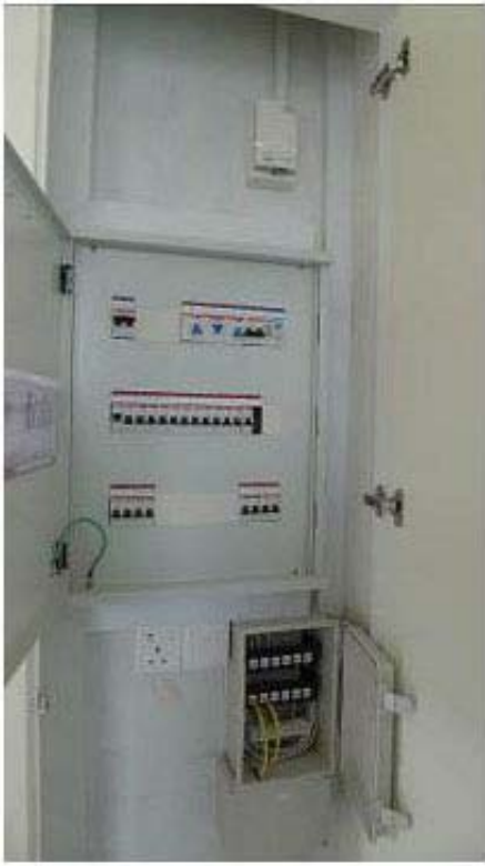
圖4. 新加坡住宅建案集中留設宅內配電箱、宅內資訊箱、光纖入口等設施
