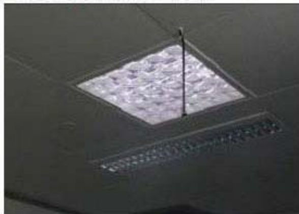
圖2. 新加坡零耗能建築於屋頂設置集光器再以光纖導入日光供室內照明使用
