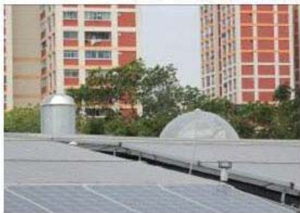
圖2. 新加坡零耗能建築於屋頂設置集光器再以光纖導入日光供室內照明使用
