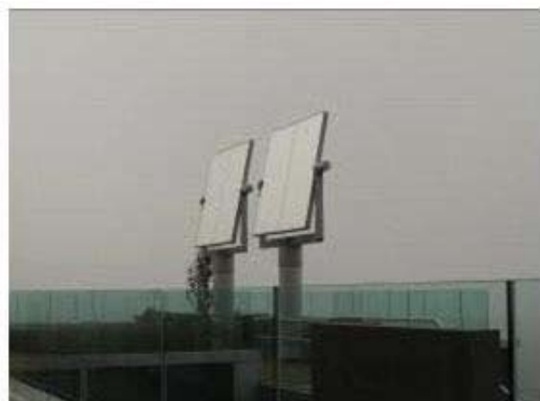
圖9. 香港科學園綠景樓採用晝光利用於頂樓內外各設置2座日光反射器
