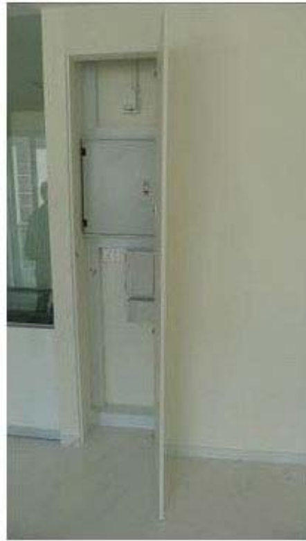
圖4. 新加坡住宅建案集中留設宅內配電箱、宅內資訊箱、光纖入口等設施
