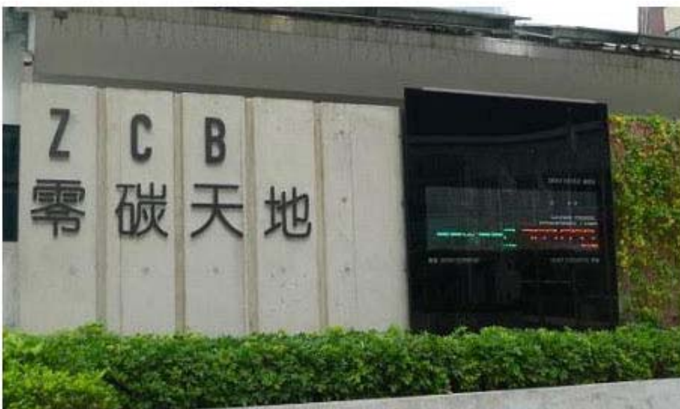
圖6. 香港零碳天地建築外牆顯示實際再生電力與建築耗電之比較
