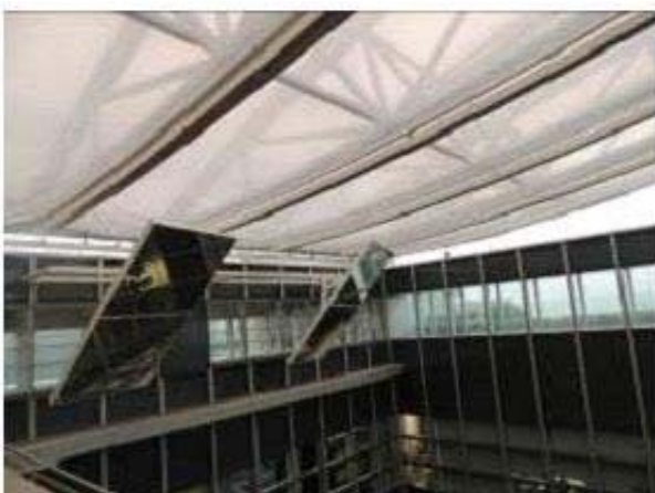
圖9. 香港科學園綠景樓採用晝光利用於頂樓內外各設置2座日光反射器
